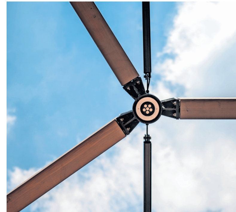
▲ De drie spanten vanaf onderaf gezien, met de verbindingselementen.
